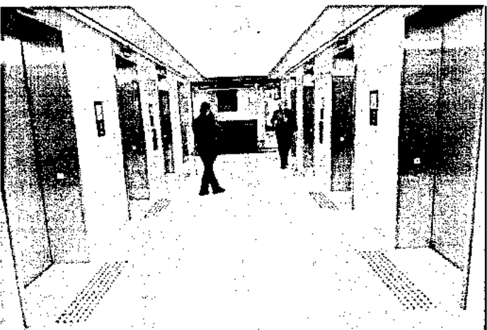
Aspecto do 13º Pavimento (hall social)
