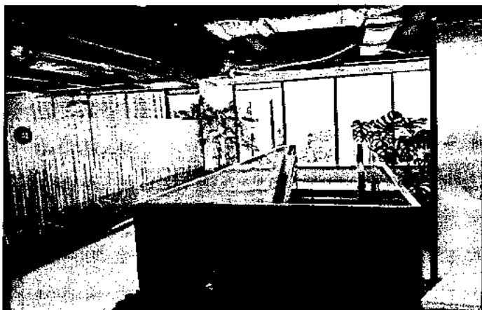
14º pavimento - (unificado com o 13º pavimento)
