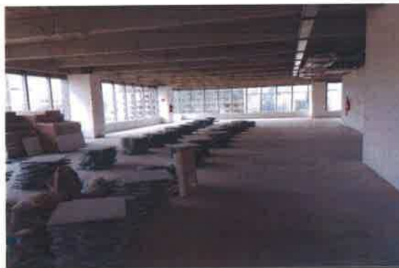
15º pavimento - Aspecto do escritório
