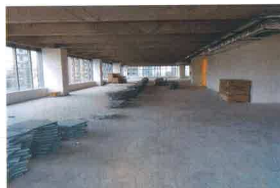
15º pavimento - Aspecto do escritório
