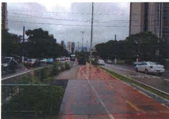
Aspecto da Avenida Chucrí Zaidan
