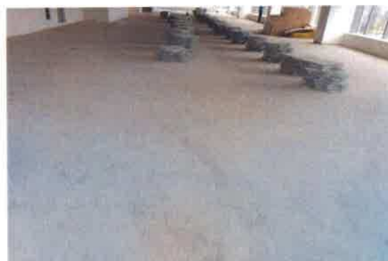
15º pavimento - Aspecto do escritório
