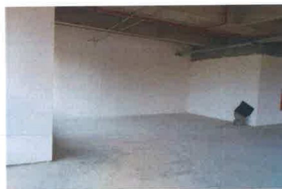
15º pavimento - Aspecto do escritório
