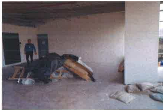
15º pavimento - Aspecto do escritório
