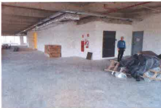
15º pavimento - Aspecto do escritório
