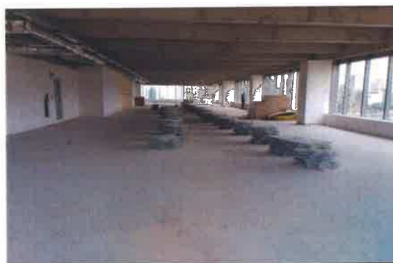
15º pavimento - Aspecto do escritório
