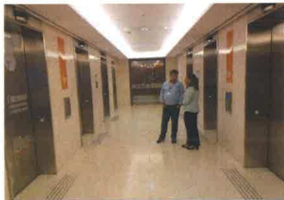
Aspecto do 9º Pavimento (hall social)
